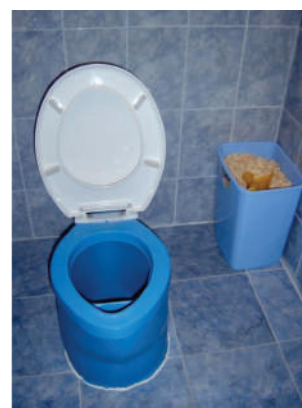
Fig. 3: Interiorul unei toalete Ecosan, Toaletă (UDDT), amplasată în interiorul unei case din Bulgaria. Foto: Earth Forever
